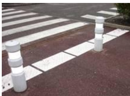
Figure 11 : Exemple de signalisation podo-tactile d'un passage piéton sur un site existant.
